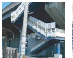
H21. 1. 県道高松大越坂出線 香西港大橋階段部
