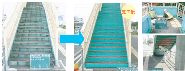
H21. 3. 柳瀬ダム大影放流警報局パンザーマスト(吉野川ダム統管事務所)
