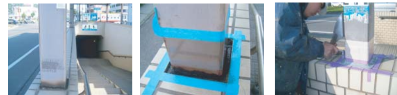
H21. 1. 国道196号南江戸地下道(平成20年度松二維持工事)
